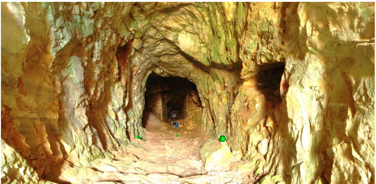
Εικόνα 12A: Τρισδιάστατη αποτύπωση της στοάς μέσα από το λογισμικό Faro Scene (5)
