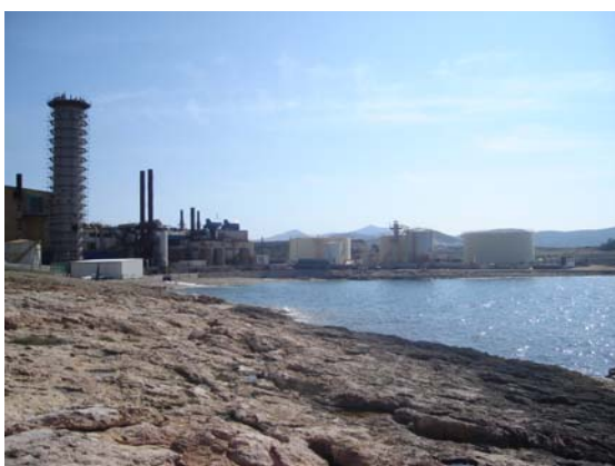
Εικόνα 2.2-1: Μερική άποψη της μονάδας της ΔΕΗ από την πλευρά της θάλασσας
