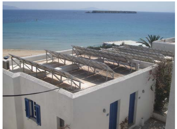
Εικόνα 2.2-4: διάταξη φ/β πλαισίων στην ταράτσα του ξενοδοχείου
